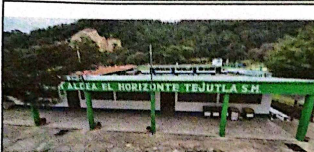
Sustitución de Techo
