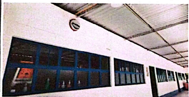
Sustitución de Ventanales de madera por ventanales de metal
