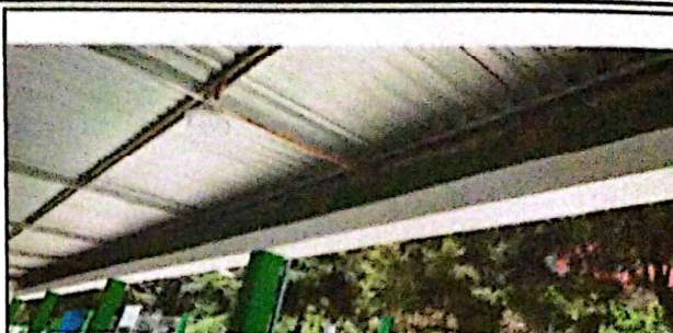
Sustitución de Techo
